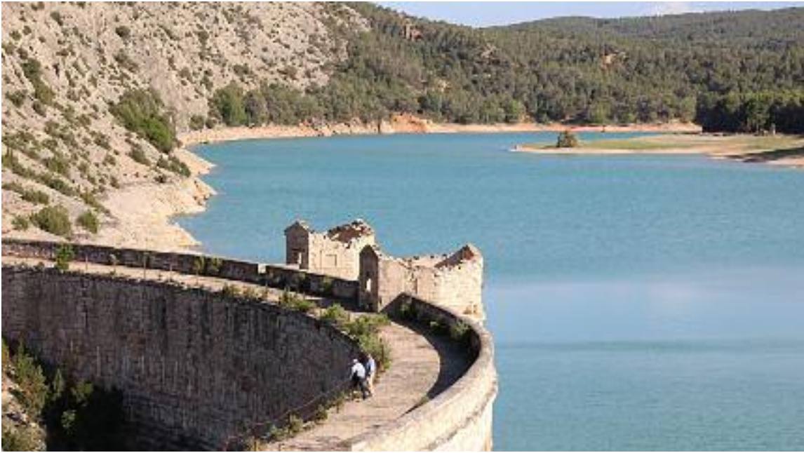
La presa del Escuriza está situada en un bello enclave paisajístico y patrimonial. Fotos: Comarca Andorra-Sierra de Arcos
