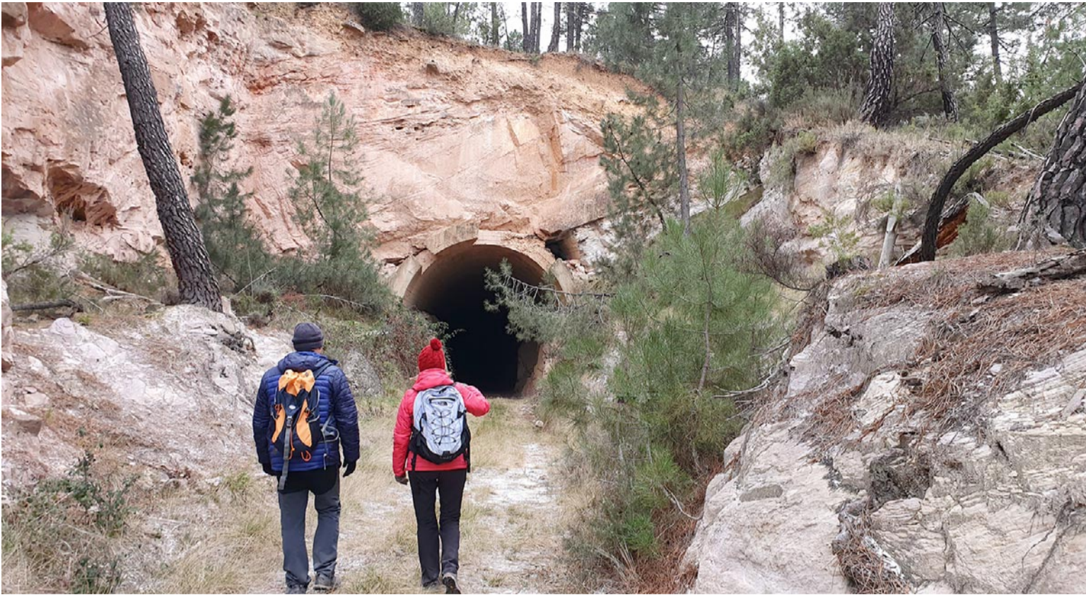
Una de las entradas al túnel de la vía del tren que nunca llegó, a la altura de Gargallo; sale del PR-TE 93 y vuelve a él. Turismo y Cultura Andorra-Sierra de Arcos
